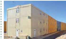
CAMPAMENTO CONSTRUCCIÓN OGP1 BECHTEL- BHPB
